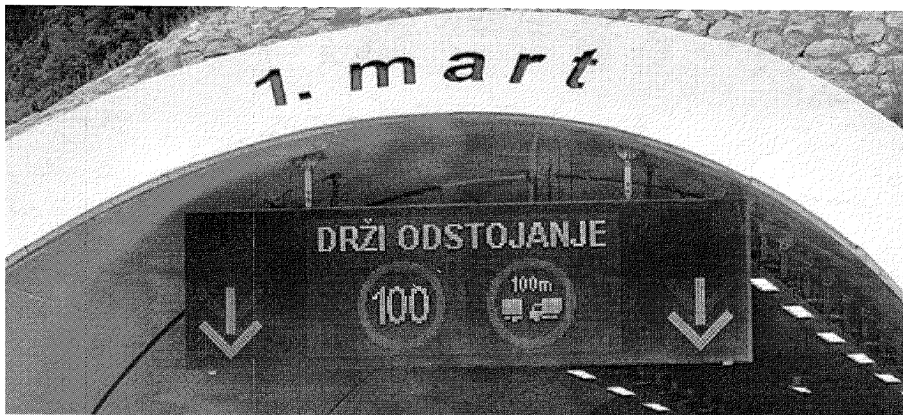
Sl.3 – Displej na stropu tunela
